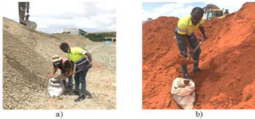
Figura 5- Recolha do material da base -ToutVenant(a) e sub-Base- Solos Musseque(b)
